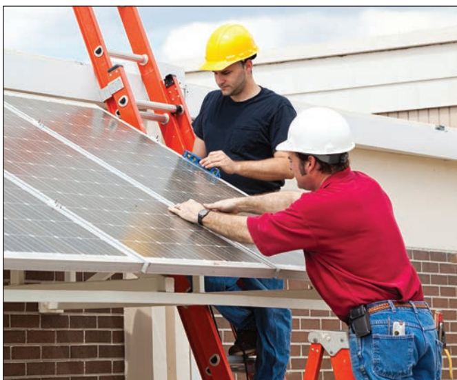
Montaż instalacji fotowoltaicznej na dachu domu jednorodzinnego
