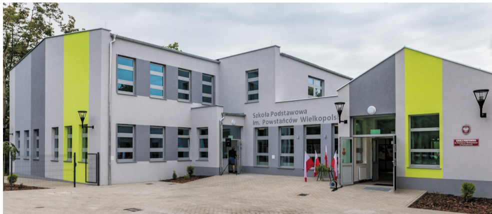
Rozbudowa szkoły w Pamiątkowie
