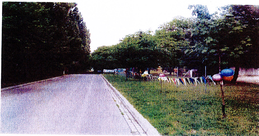
Droga dojazdowa do terenu sportowo-rekreacyjnego w Mutowie
